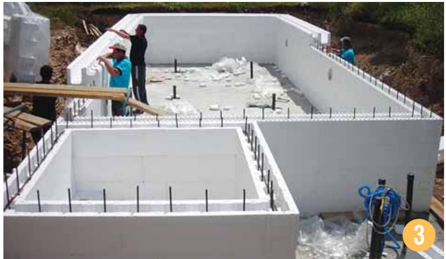
Stropool RECTON-TM Denge Tankı ve Taşmalı Perde Duvar Montajı
