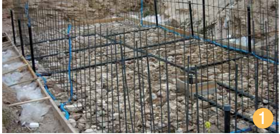
Stropool RECTON-TM zemin demir döşemesi
