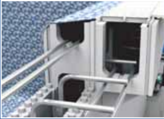
Membranlı Üstten Taşma Detayı (İzgara sonrası Kaymazlar Opsiyoneldir)
