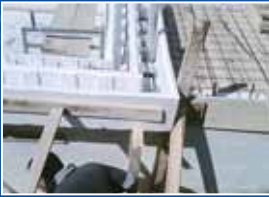
Üstten Taşmalı Stropor Tuğla Köşe Detayı 3
