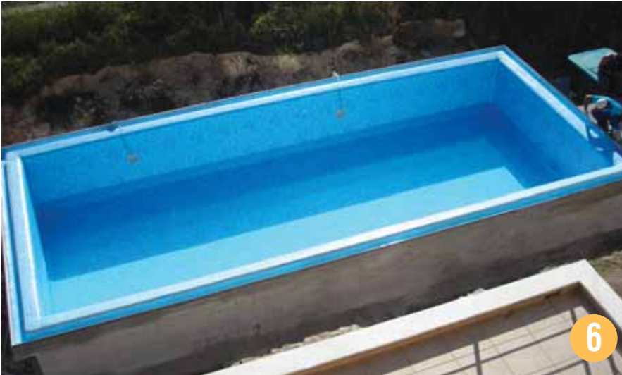
Stropool RECTON-TM Membran kaplama işlemi tamamlanmış, Taşma Kanalları Poliüretanla izole edilmiş ve kısmen doldurulmuş havuz.
