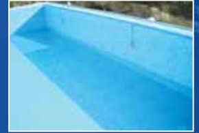
Üstten Taşmalı Havuzun Membran Montajı sonrası İç Görünümü
